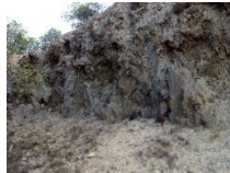
PARED DE YESO (JUNTO A CAMINO DEL ALTO)
